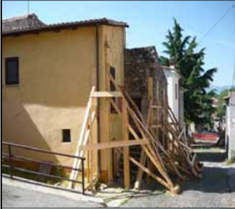
Puntellamento facciata e d'angolo per contrastare il meccanismo di ribaltamento
