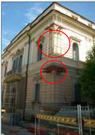
Cerchiature perimetrali con tiranti metallici in corrispondenza di ogni solaio al fine di ridare all'edificio un comportamento scatolare
