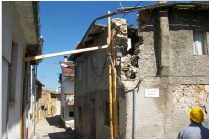
Puntellamento di contrasto per bloccare l'instabilità verticale della parete
