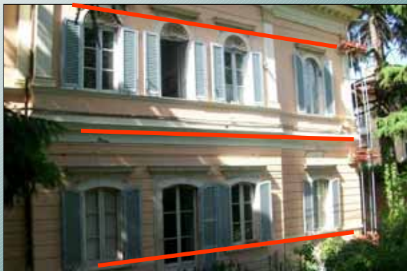
Cerchiature perimetrali con tiranti metallici in corrispondenza di ogni solaio al fine di ridare all'edificio un comportamento scatolare
