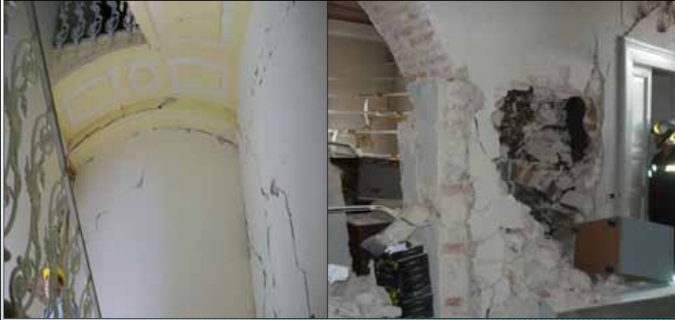
Corpo scala completamente lesionato
