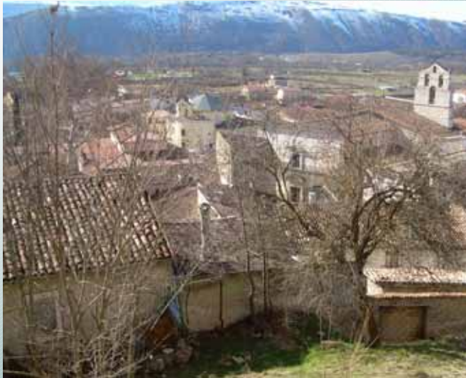
PAGANICA VECCHIA VISTA DELL'ABITATO DAL SERBATOIO
